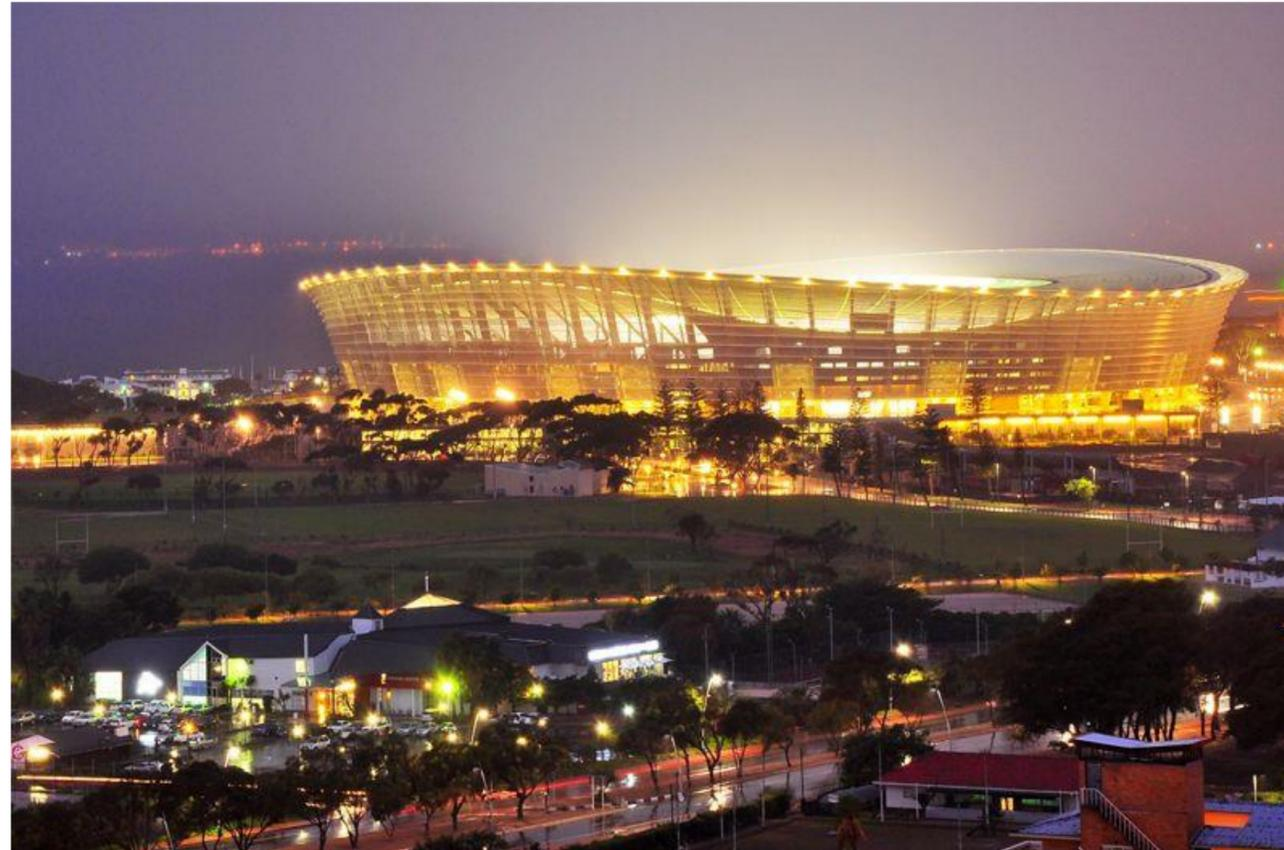
Das Besondere an diesem Stadion ist neben dem markanten wellenförmigen Dach sein spektakuläres Layout. Die Sportstruktur ist komplett mit halbtransparentem Fiberglas bedeckt, was das Innere enthüllt. Je nach Wetterlage verändert dieses Material die Farbe des Stadions: weiß, während des sonnigen Tages, grau an bewölkten Tagen und rötlich bei Sonnenuntergang. Nachts wird es transparent und von 360 Lampen beleuchtet, wodurch ein unglaublicher Effekt entsteht.
